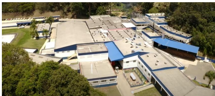
Planta frigorífica de Bocaíuva do Sul/PR.
