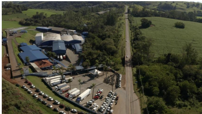
Complexo Industrial de Iporã/PR.
